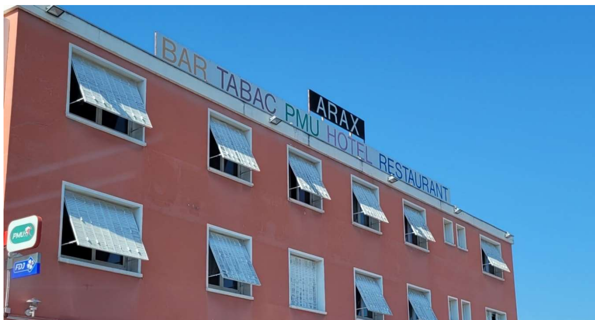
Panneaux en toiture
