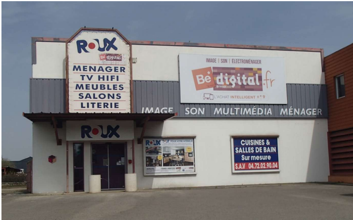
Surface d'enseignes trop importante en pourcentage de la façade
