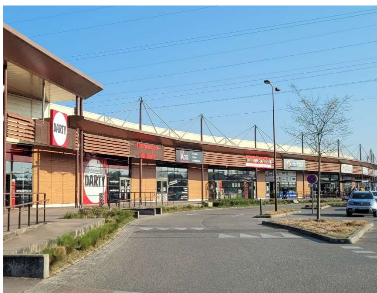
Enseignes parallèles aux murs
