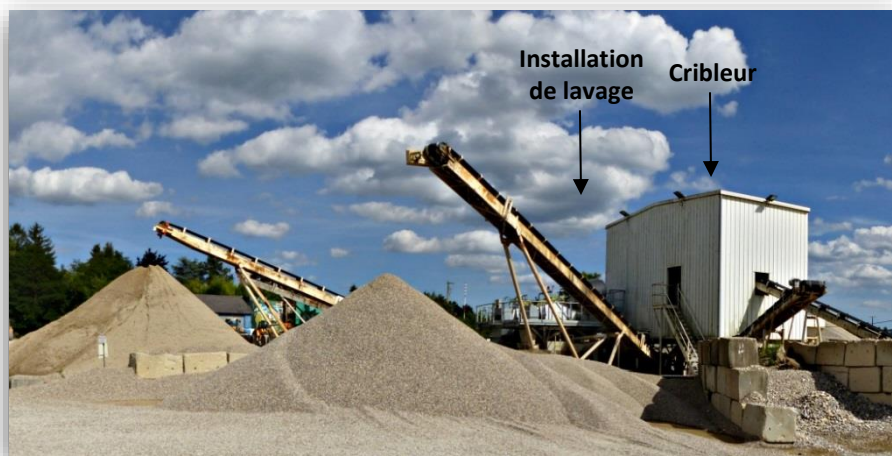
Installation fixe de traitement
