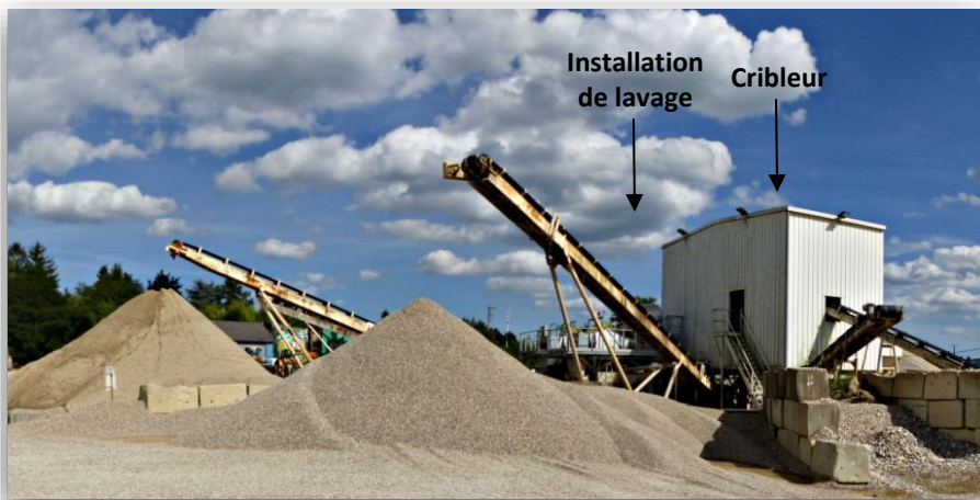
Installation fixe de traitement
